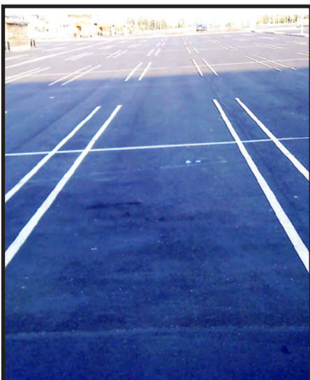
GOD IDE: Ved Sørlandssenteret har de merket opp et eget felt på ca 35 cm mellom parkeringsplassene.
